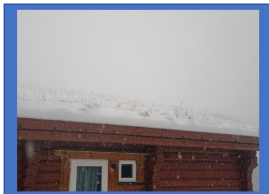
Bild 2: Snötäckt sedumtak. Ej besiktningsbart.
