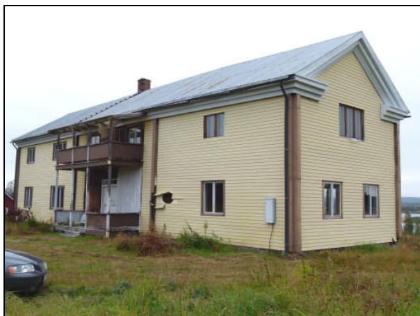
MG_E_002. Från söder innan plåten avlägsnats.
