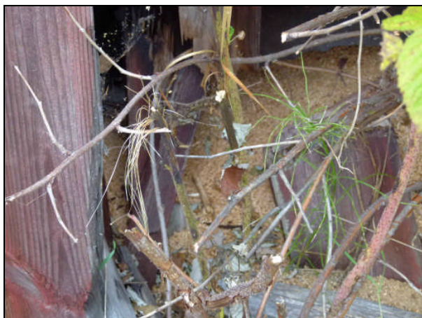
BU_E_011. Skadad panel och spån på väg ut.
