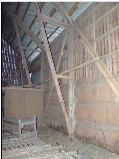
LS_I_001. Bärande konstruktion.
