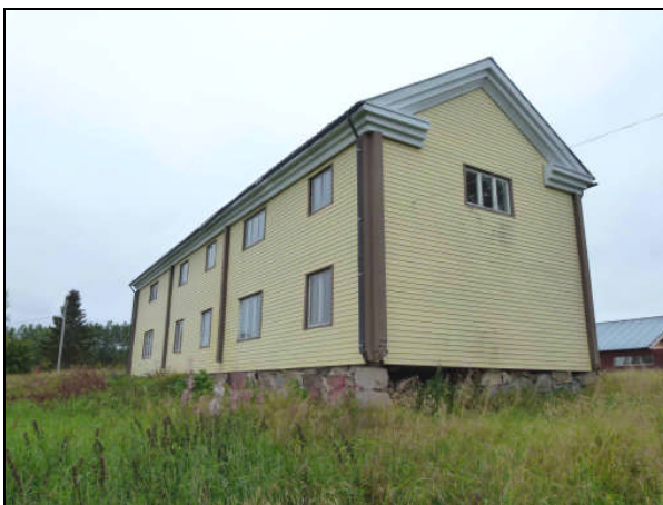
MG_E_001. Från norr innan plåten avlägsnats.
