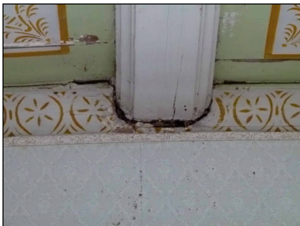
MG_I_102_004. Vägg/tak i pörtet.
