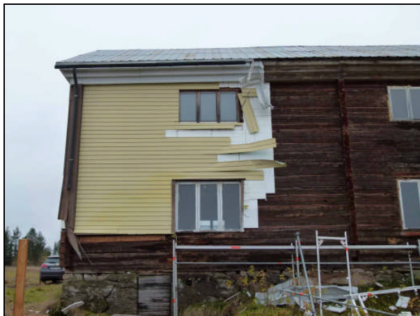
MG_E_059. Södra delen av nordöstra fasaden.
