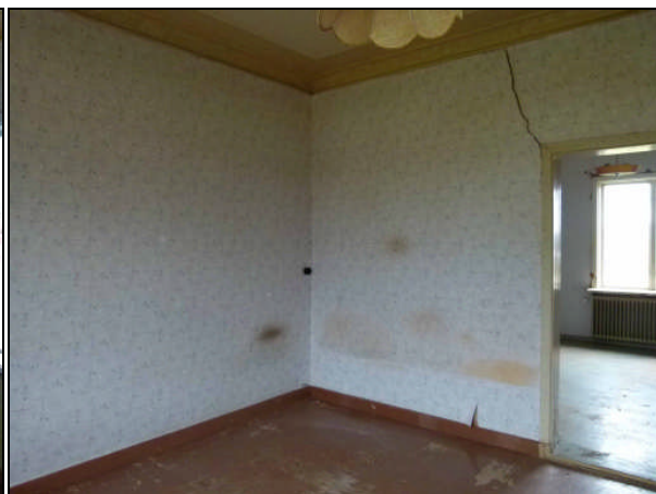
MG_I_107_004. Rummet mot norr. 106 till höger.
