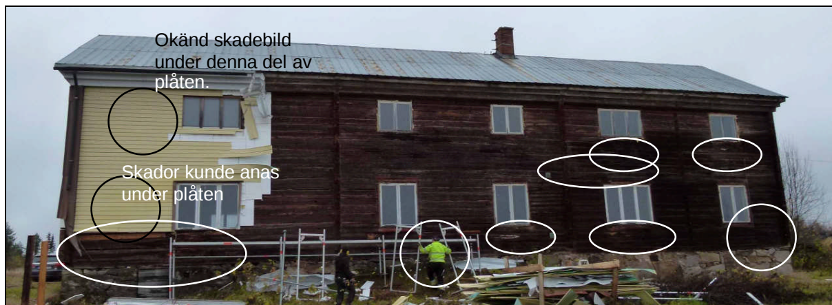
MG_E_058. Fasad mot nordöst. Se även MG_E_059, 062 och 066 i bildbilagan.
