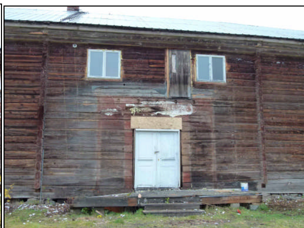
MG_E_080. Mitten av sydvästra fasaden.
