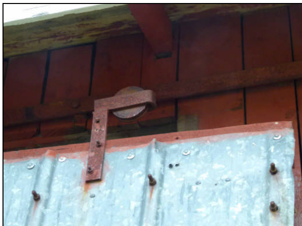
LL_E_004. Skjutdörrsbeslag.
