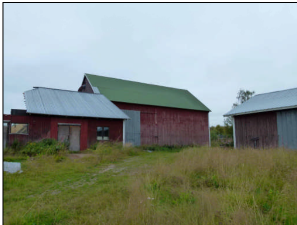
LS_E_005. Ladan från sydost
