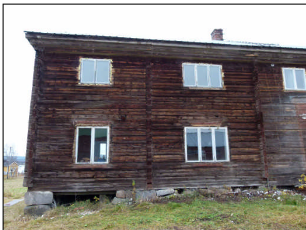
MG_E_075. Norra delen av sydvästra fasaden.
