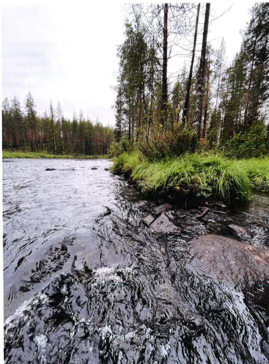
Bild 6. Exempel på en överväxt riskista i Verbobäcken. Riskistor är en äldre typ av konstruktion som gjordes främst för att kanalisera vattendragen där det kunde finnas en lugnare vik eller liknande där timret kunde fastna under sin färd utför vattendraget. Då sprängde man ofta stora block i vattendragen och lade sedan skärvor av dessa ovanpå jord, ris och bräte så att detta skulle ligga kvar. Dagens skick på riskistor vittnar om att det var en effektiv konstruktion. Många av dessa är ganska intakta och det växer ofta träd på dessa konstruktioner. Dessa kistor vill man gärna ta bort så att vattendraget kan återfå sin naturliga bredd. De sprängda blocken ersätts gärna med större block på land i nära anslutning till objekten.
