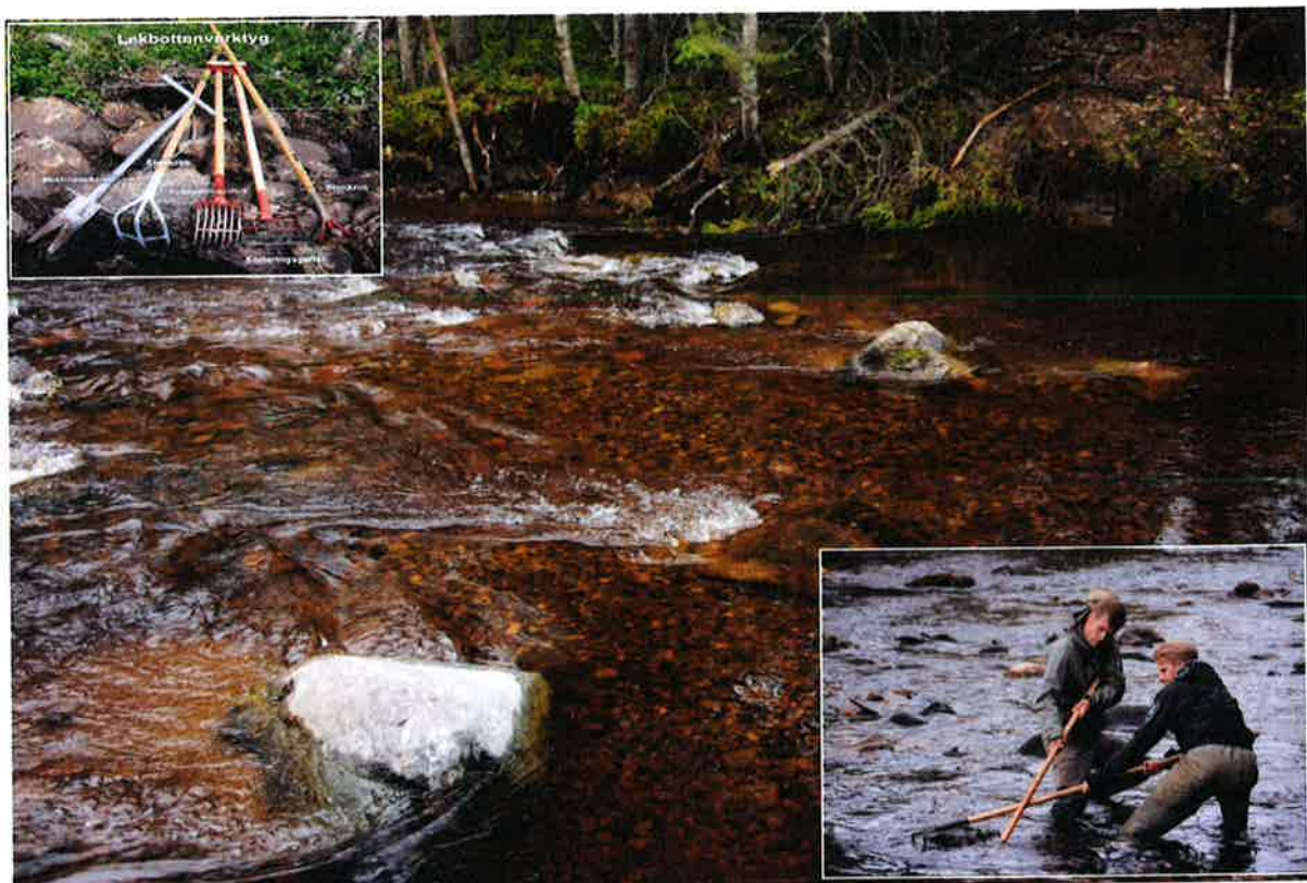
Bild 4. Fotomontage över återskapad lekbotten för fiskar. Denna lekbotten har först konstruerats av grävmaskin för att sedan för hand finjusteras med manuella verktyg som syns uppe till vänster i bild. Block och sten förflyttas för hand för att uppnå önskad vattenhastighet och kornstorlek.
