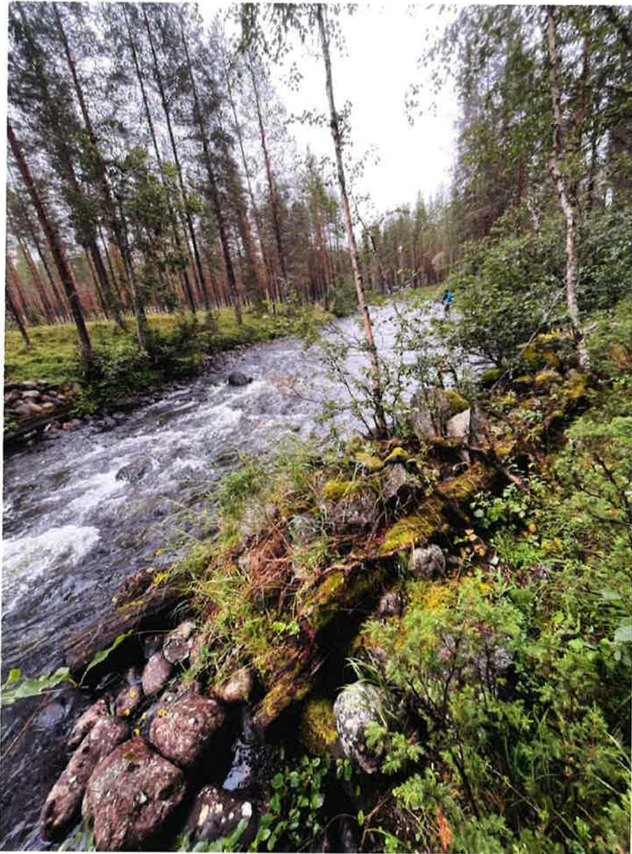
Bild 5. Bild på en delvis förfallen dubbelkista bestående av upprepade block och timmer. Dessa flottledskonstruktioner byggdes bland annat för att rensa vattendraget på sten och block, kanalisera, samt för att göra vattendraget smalare. Dessa kistor plockas bort för att uppnå ursprunglig bredd på vattendraget. Materialet som enkelkistan består av placeras åter ut i vattendraget. De gamla timmerstockarna används med fördel för att läggas i vattendraget som så kallad "dödved" vilket är en väldigt viktig del i ett naturligt vattendrag.
