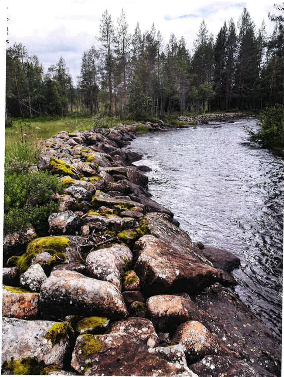
Bild 7. Bildexempel på en rensning i Verbobäcken, i kartmaterialet benämnda antingen som "rensvall" eller "sporadisk rensning". Här visas en rensad sträcka med inslag av sprängda block. De rensade blocken är delvis upplagda mot den gamla ursprungliga strandzonen och delvis för att spärra av ett tidigare bakvatten. På så vis skapat en ny strandzon längre ut i vattendraget, vilket resulterat i en kanalisering av vattendraget och en försämrad kontakt med skogen intill. Sträckan har efter denna rensning en brist på variation i djup och större block. Vid restaureringsåtgärd avtäckts all eventuell vegetation från rensningen, detta återanvänds sedan på den nyskapade strandzonen. Sedan sorteras materialet i rensningen, sprängda skärvor separeras och grävs ned djupt i bottenstrukturer medan natursten återbördas till bäckfäran. I och med detta återfår vattendraget sin naturliga bredd samt ett naturligt intryck.
