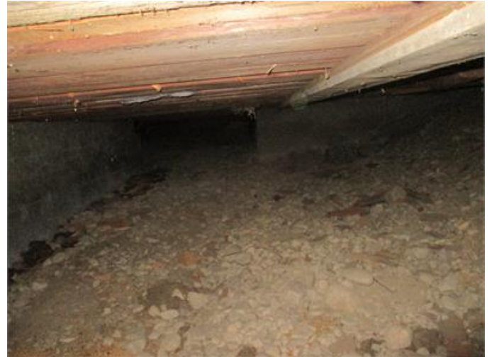
Krypgrund äldre del bild genom ventil i grundmur
