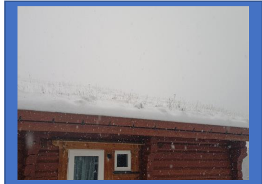
Bild 2: Snötäckt sedumtak. Ej besiktningsbart.
