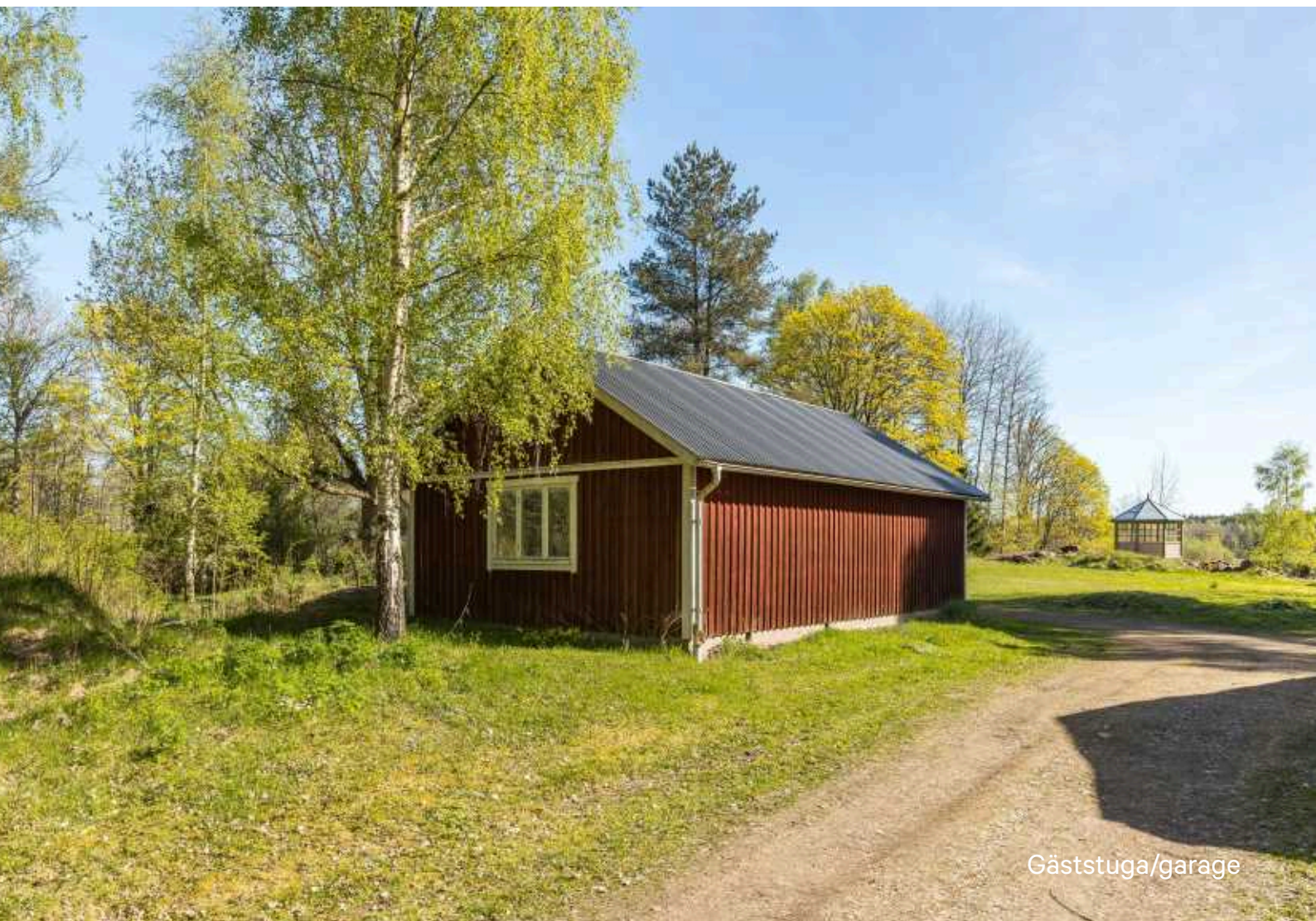
Gäststuga/garage och traktorgarage
