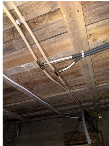
Isolera tappvattenledningar i torpargrunden.
